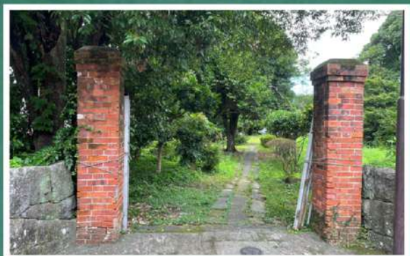
千々石ホテルの跡地
